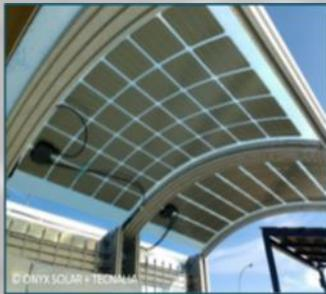
Las nuevas soluciones tecnológicas que se plantean en el marco del proyecto tienen una serie de ventajas respecto a la tecnología fotovoltaica actual. No solamente producen electricidad, sino que tienen buena estética (colores, texturas), aislamiento térmico, o funciones de protección. Sustituyen así a los materiales de construcción convencionales ahorrándonos este coste y consiguiendo un retorno de la inversión por la producción eléctrica.
